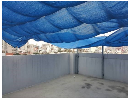
頂樓防曬工程
